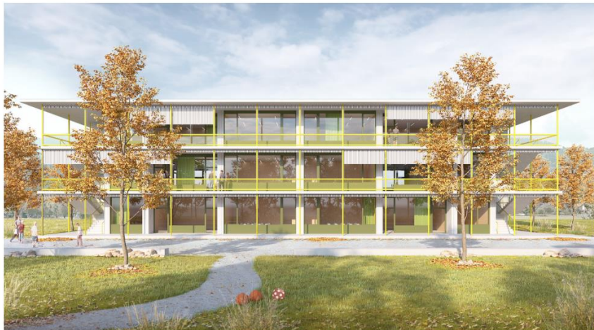
Blick vom Ort, Binnensicht, Schulgebäude
